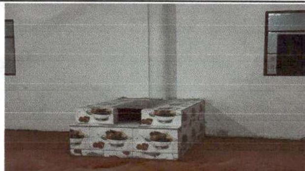
Foto 4: Sustitución de estufa rural, que incluye chimenea y plancha de metal, en módulo de cocina.
