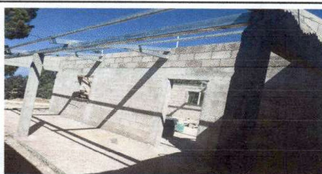
Foto 6: Instalación de estructura metálica portante en el módulo de cocina.
