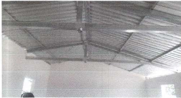
Foto 1: Sustitucion de lamina, por lamina troquelada Aluzinc calibre 26 en modulo de cocina
