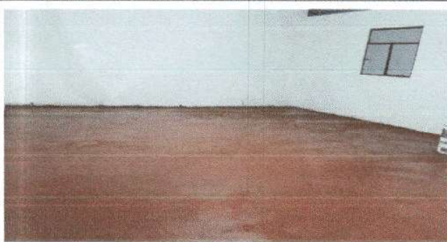
Foto 3: Sustitucion de piso de torta de concreto en modulo de cocina.
