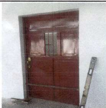
Foto 1: Fabricación e instalación de puerta de metal en módulo de cocina.
