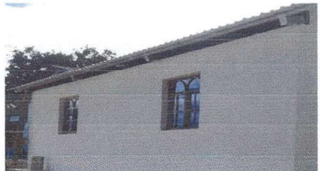
Foto 2: Sustitucion de ventana de madera por metal mas vidrio en modulo de cocina
