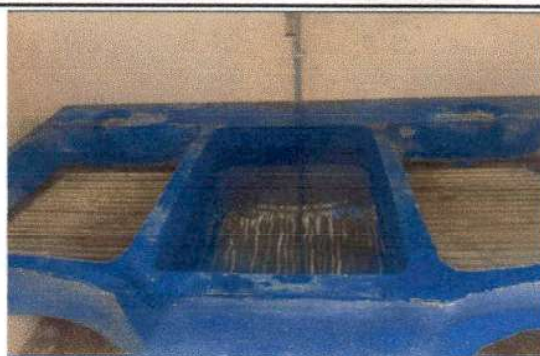
Foto 2: Instalación de tubería para agua potable en módulo de cocina.
