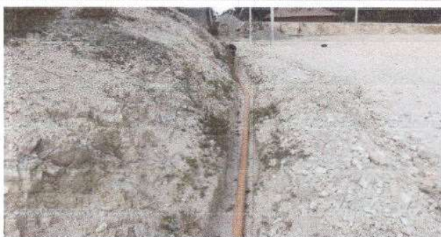
Foto 5: Sustitucion de tuberia pvc lineal principal aguas negras en modulo cocina.
